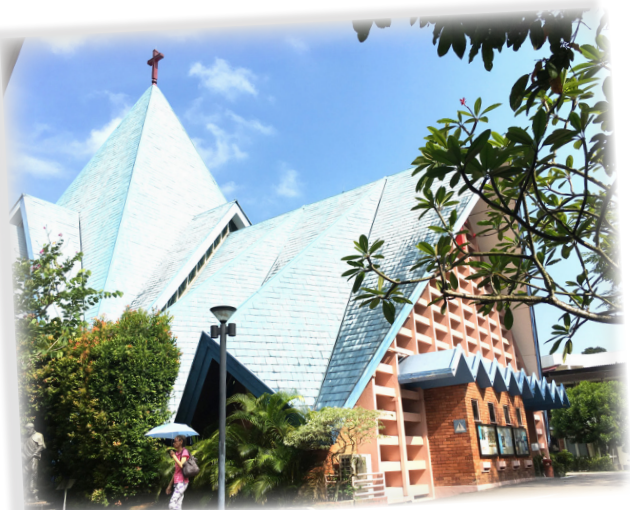
圣体堂的屋顶隐喻帐幕
